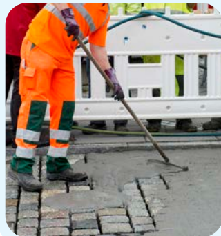
Step 5 Pour tufftop over wet paving
